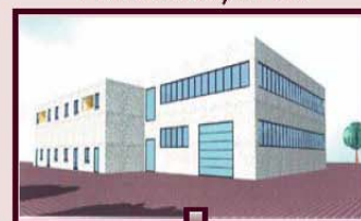
Impianto già in uso Plant already in use
